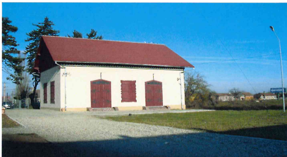
Casa stavilar - suprastructura
