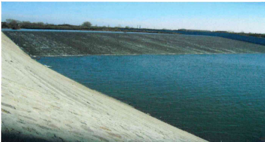
Vedere din aval a barajului stavilar
