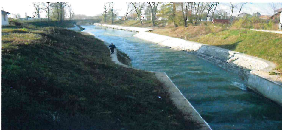
Canalul si dissipatorul aval de casa stavilar
