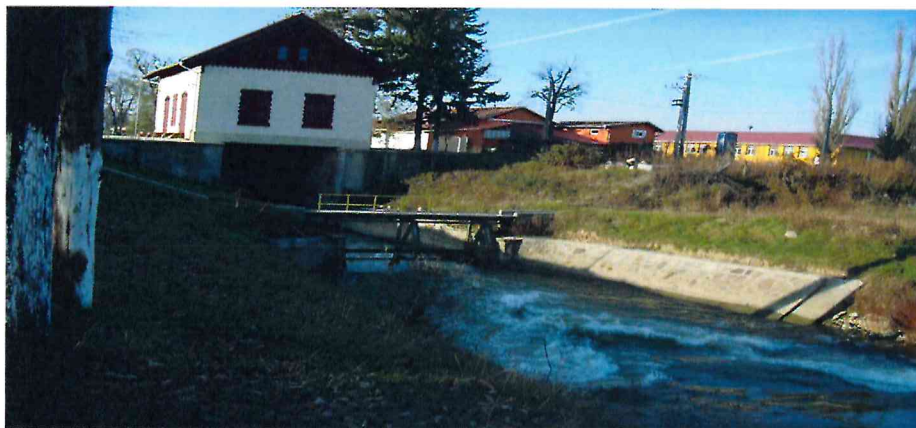
Canalul de acces la casa stavilarului
